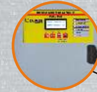
Ηλεκτρικός πίνακας ελέγχου αερολέβητα
